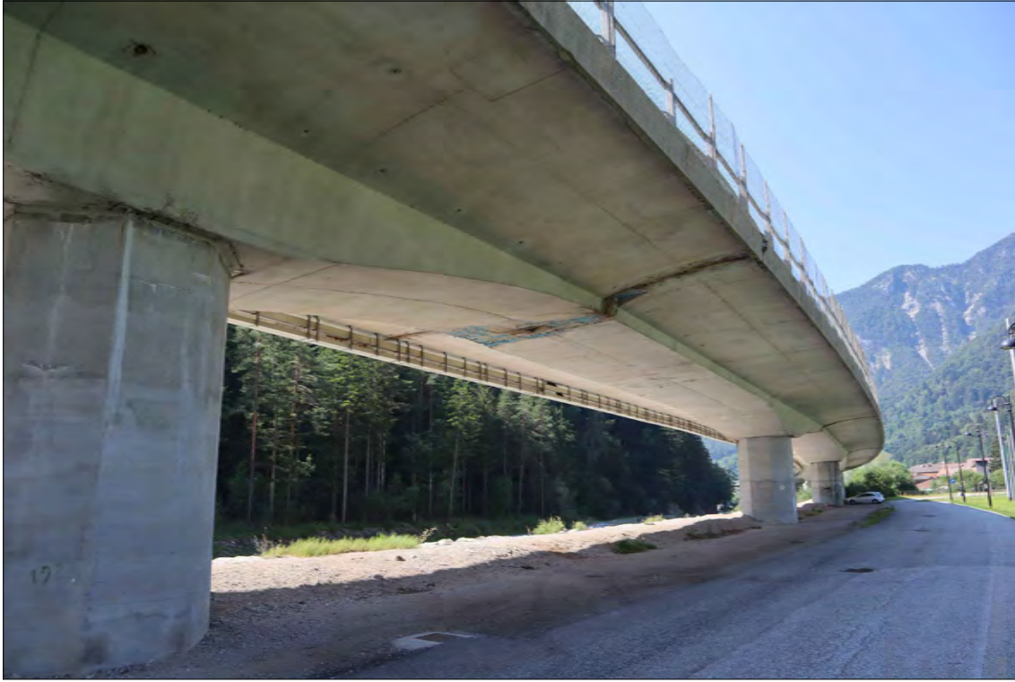
Rilievo 4 Emme - Appoggi Gerber
