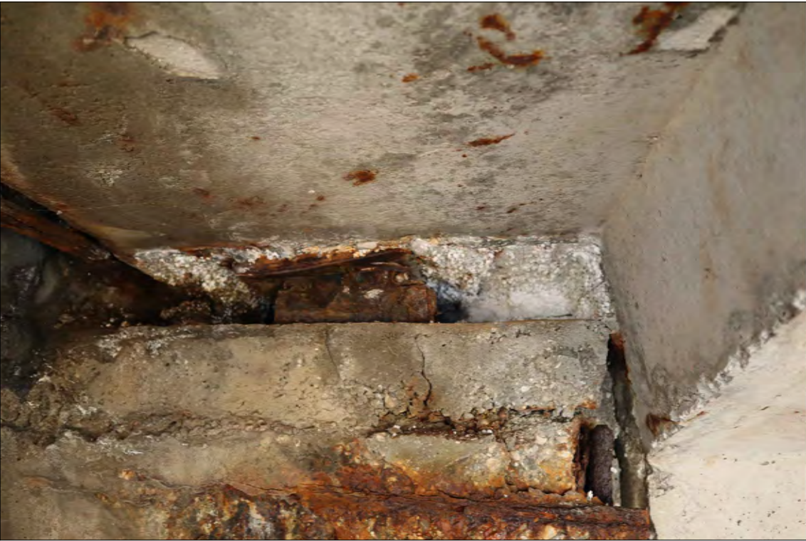
Rilievo 4 Emme - Appoggi Gerber
