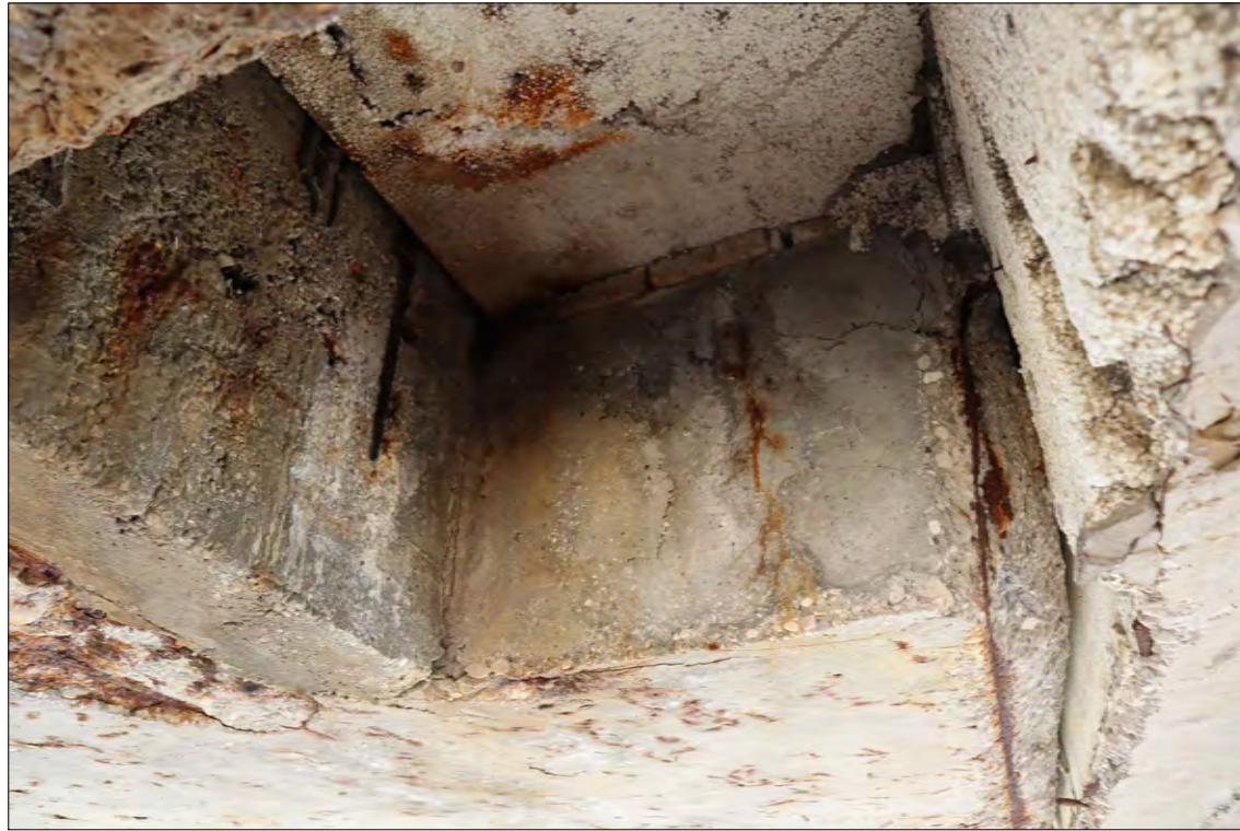
Rilievo 4 Emme - Appoggi Gerber
