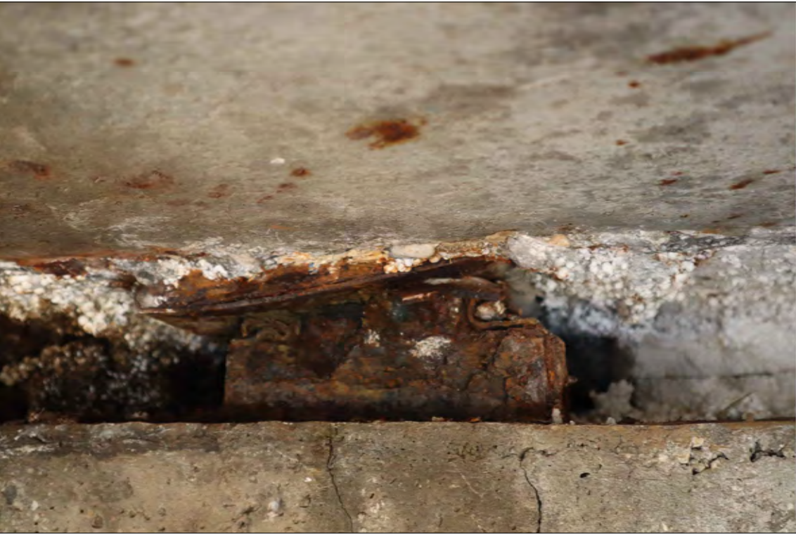
Rilievo 4 Emme - Appoggi Gerber
