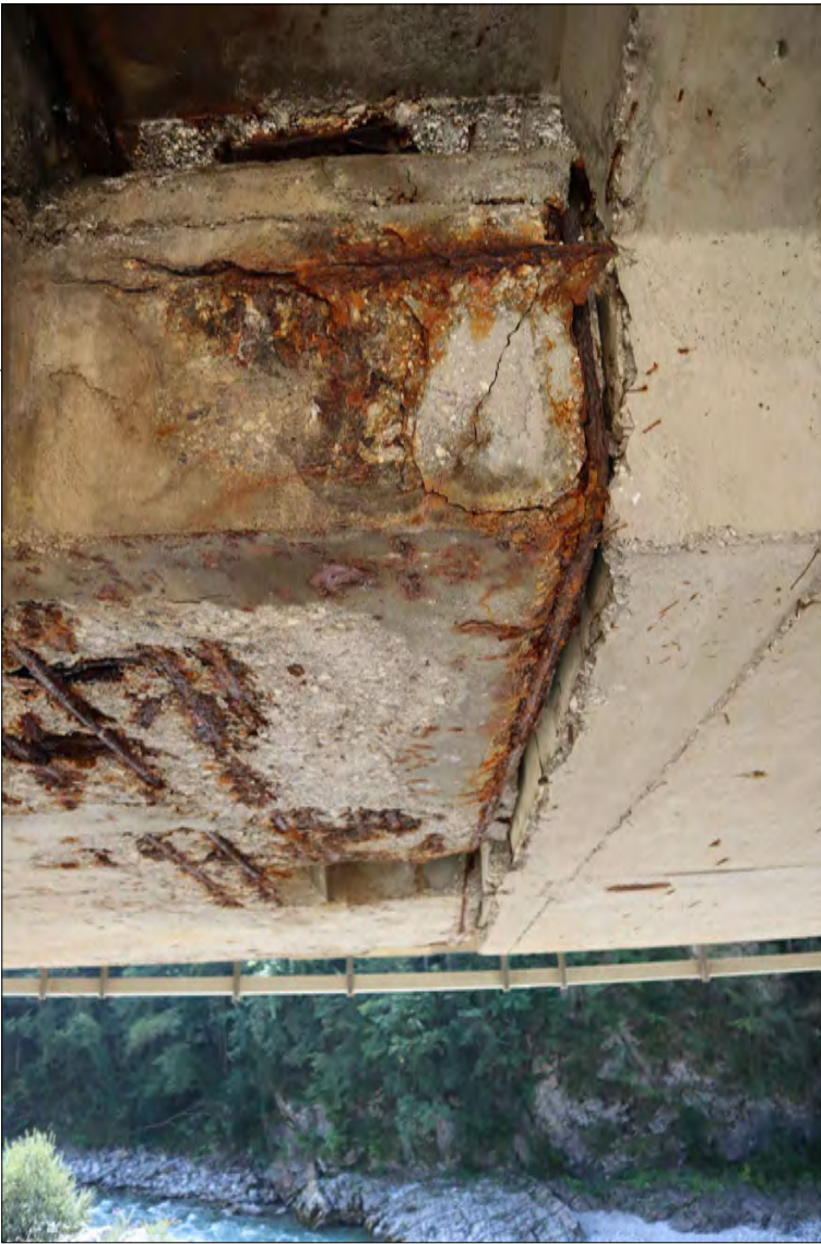
Rilievo 4 Emme - Appoggi Gerber
